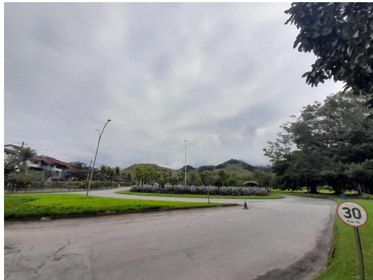
Vista do Imóvel - Fonte: BRCC
