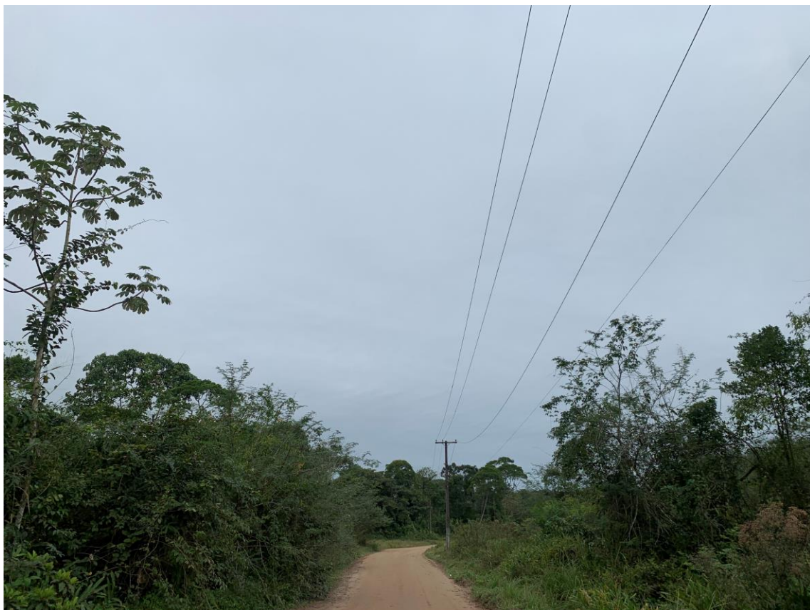
Vista do Imóvel - Fonte: BRCC
