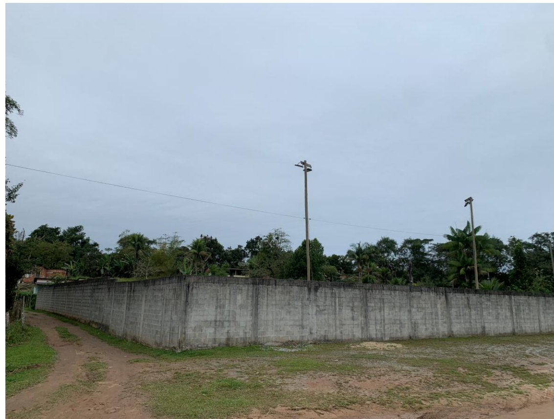
Vista do Imóvel - Fonte: BRCC
