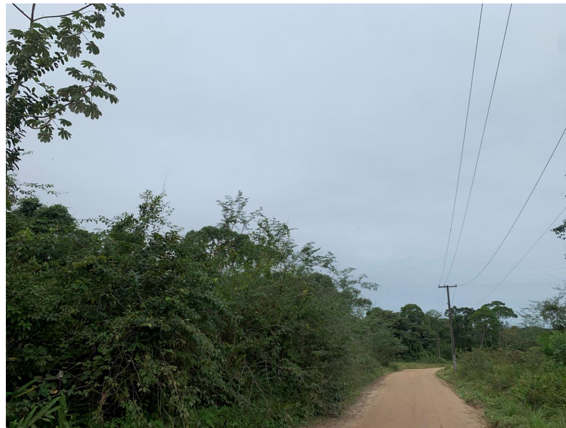
Vista do Imóvel - Fonte: BRCC
