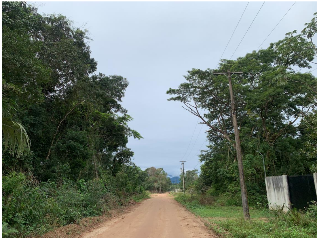
Vista do Imóvel - Fonte: BRCC
