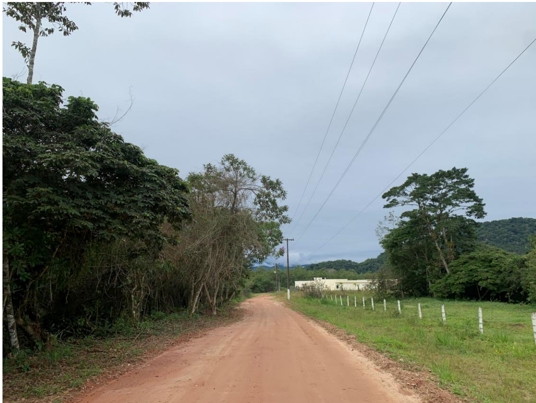
Vista do Imóvel - Fonte: BRCC
